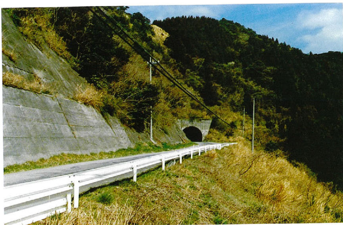
付替県道と川谷トンネルL=364m 現国道410号線
