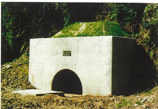
用水トンネル
