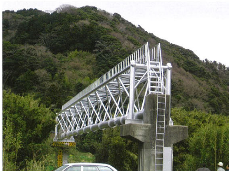
平久里川水管橋 H17
