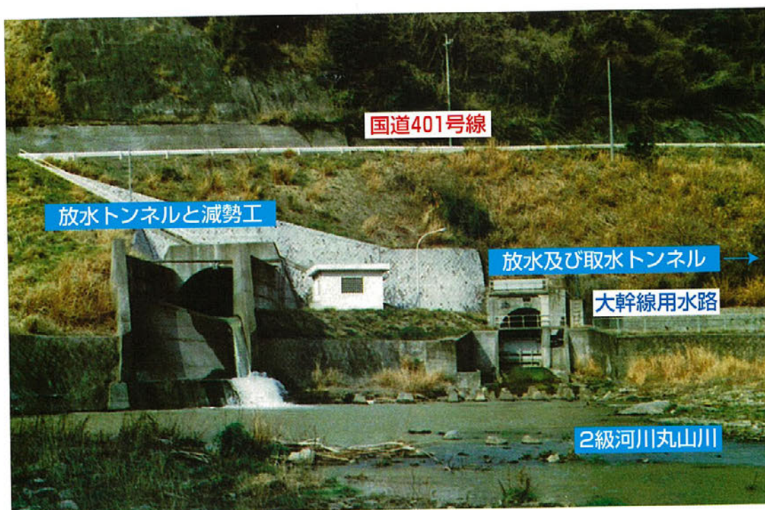
余水吐トンネルと減勢工及び取水トンネル
