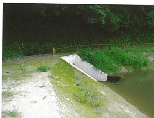
改修された余水吐
