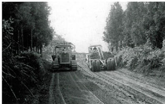
土取り場での用土運搬、キャリアオーバー スクレパーをBD17ブルドーザーで牽引
