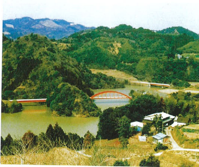
安房中央ダム
