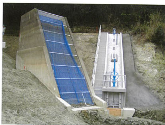
整備された土砂吐工
