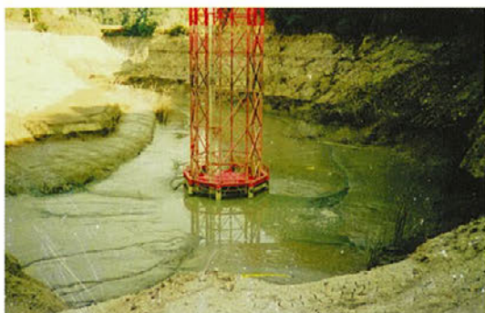
老朽化進む取水設備
