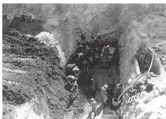
堤体基礎部の処理作業
