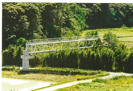
平久里川水管橋
