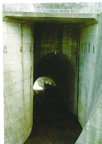
放水トンネル Qmax617m 3 /s
