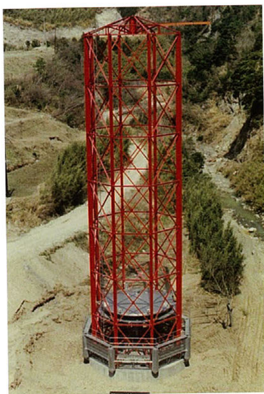
フローティングタイプ取水塔
