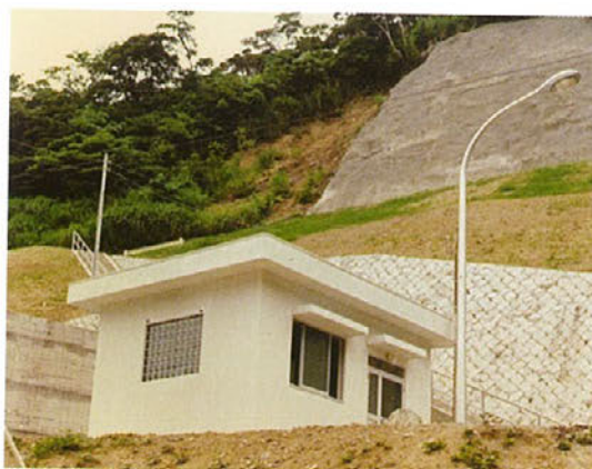
取水設備操作室
