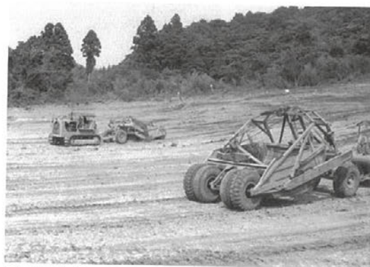
盛土用土取り場、シュートまでスクレーパー等で運ばれた
