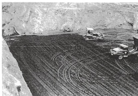
堤体基礎部の盛土と転圧作業
