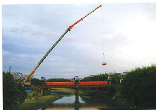
巻揚げ機架設作業
