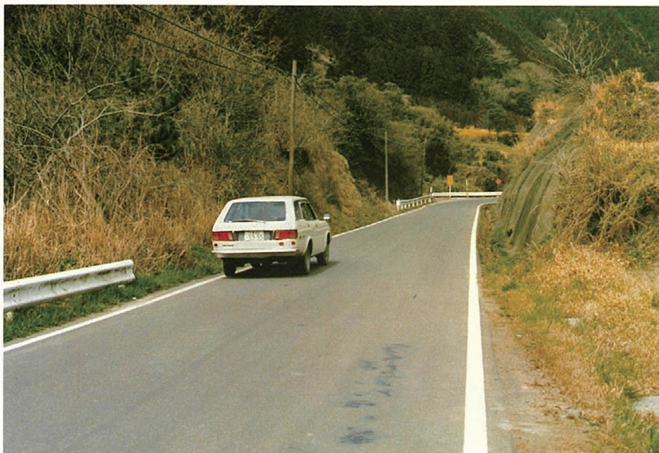
付替県道（終点付近から丸山橋付近）
