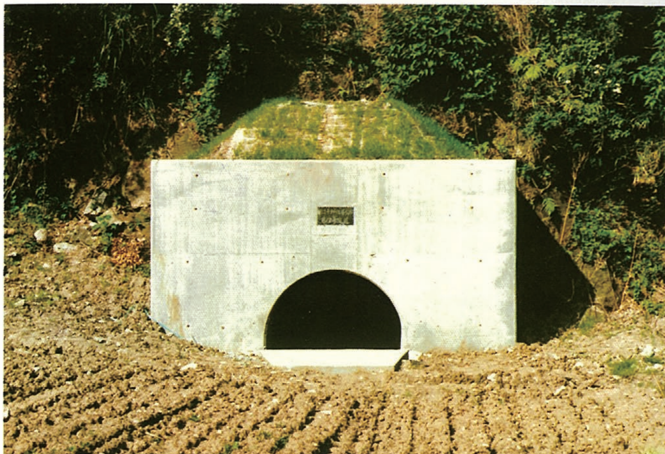
用水路トンネル完成
