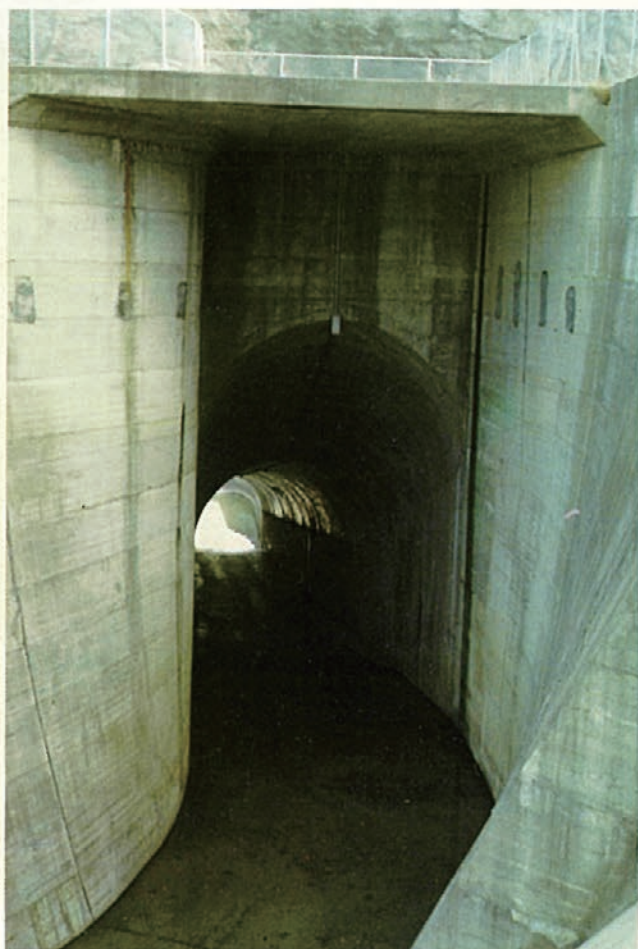
余水吐放水トンネル
