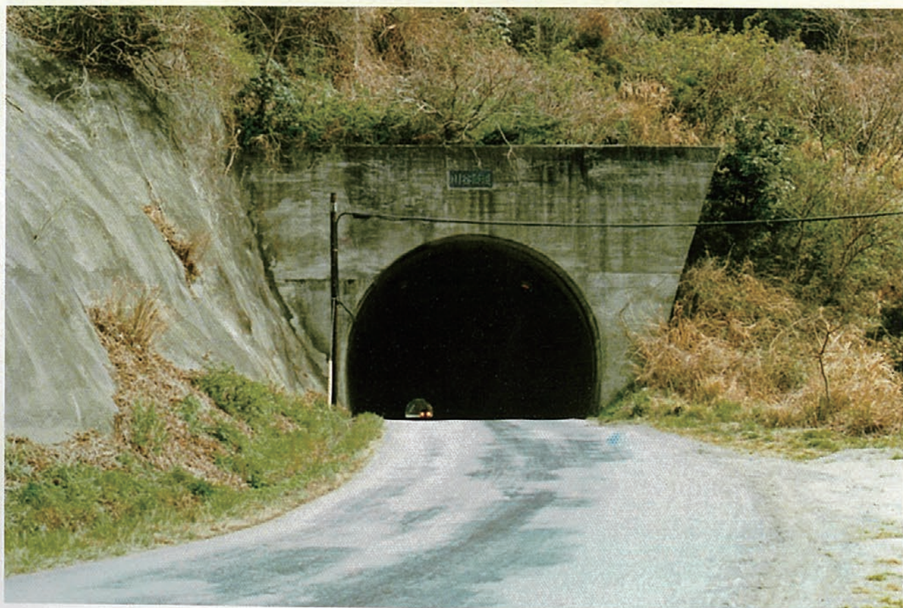
付替県道（川谷隧道）
