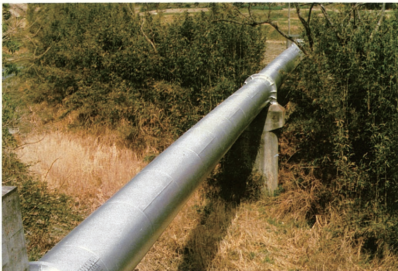
大幹線用水路水管橋
