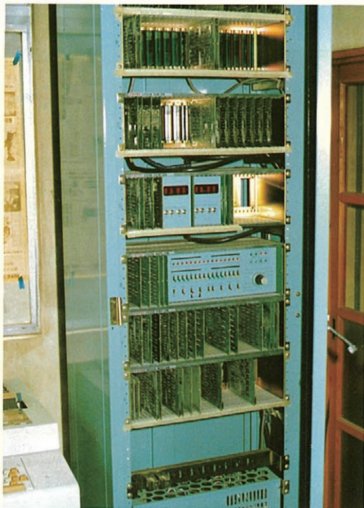
ダム管理室内（幹線水路用水監視装置、操作盤及びタイプライター）
