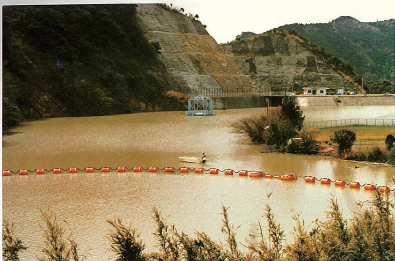
ダム満水状態
