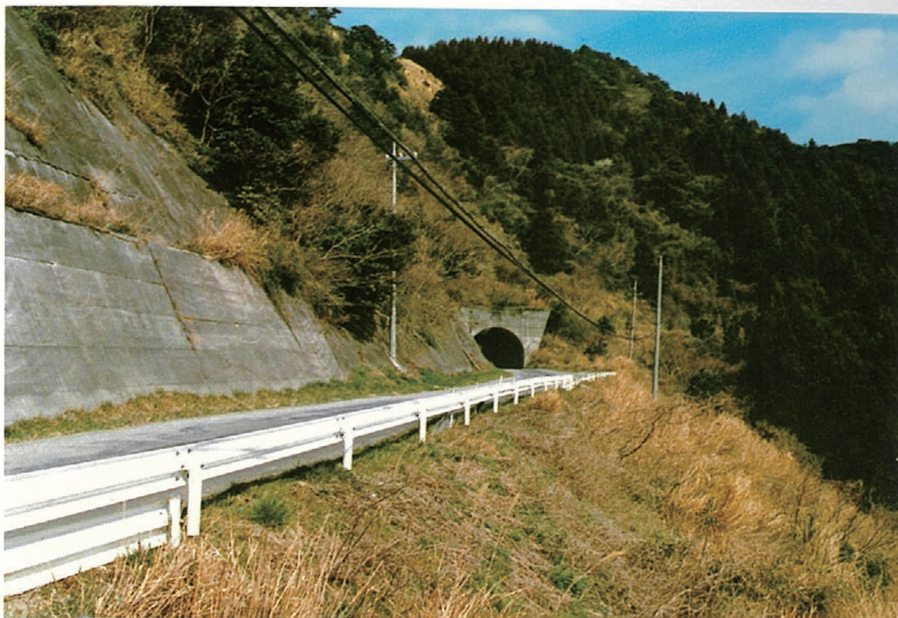
付替県道（始点付近から川谷隧道を望む）
