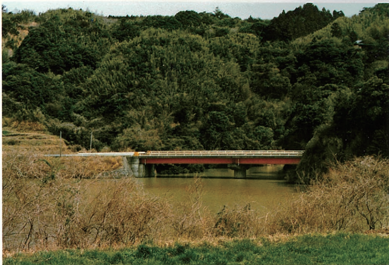
付替県道 丸山橋
