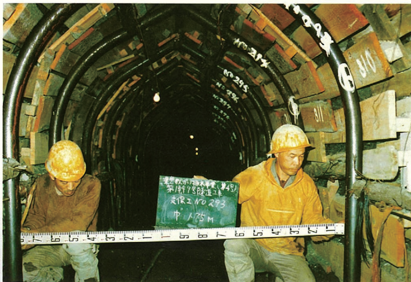
用水路トンネル掘削工
