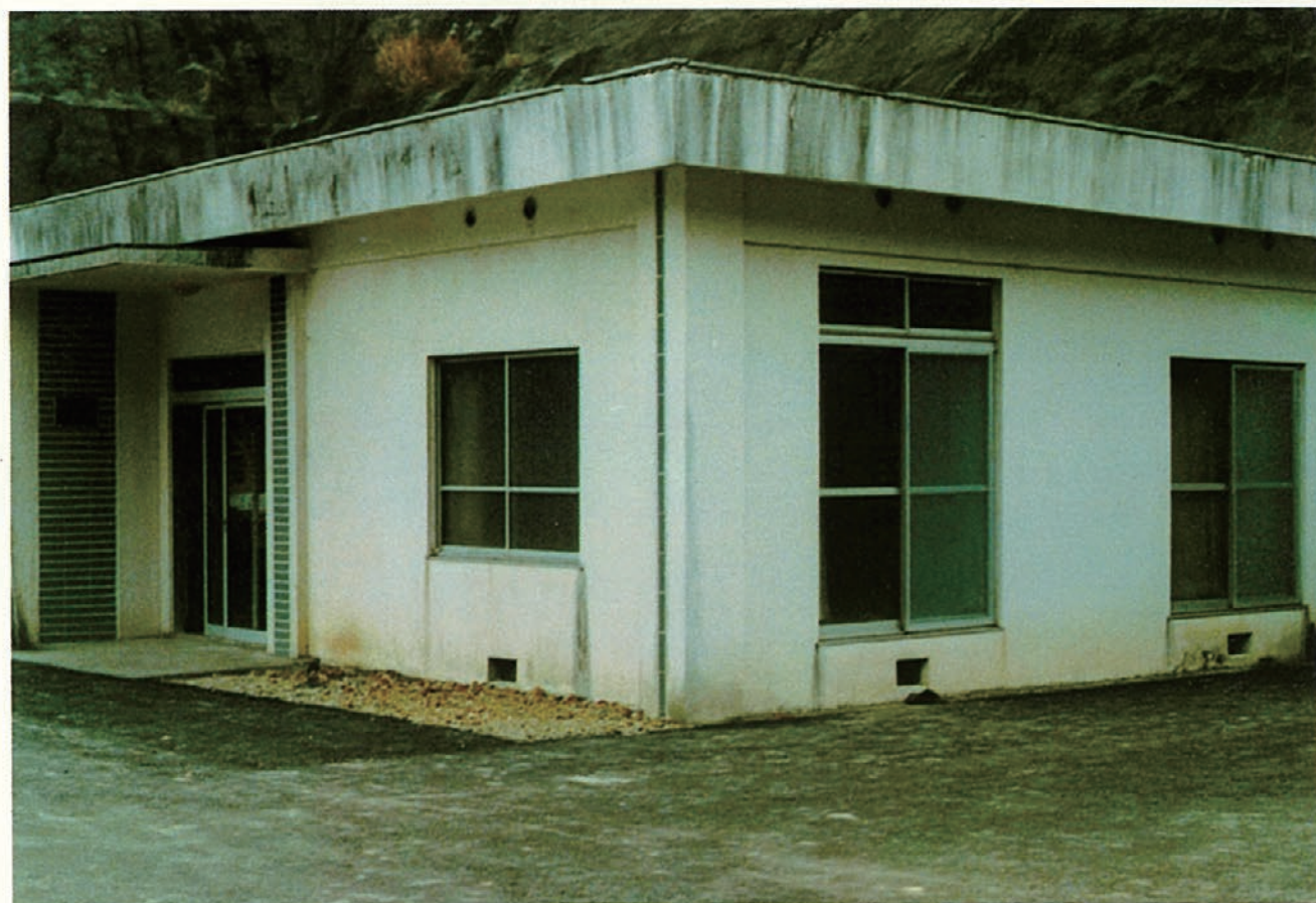
ダム管理事務所
