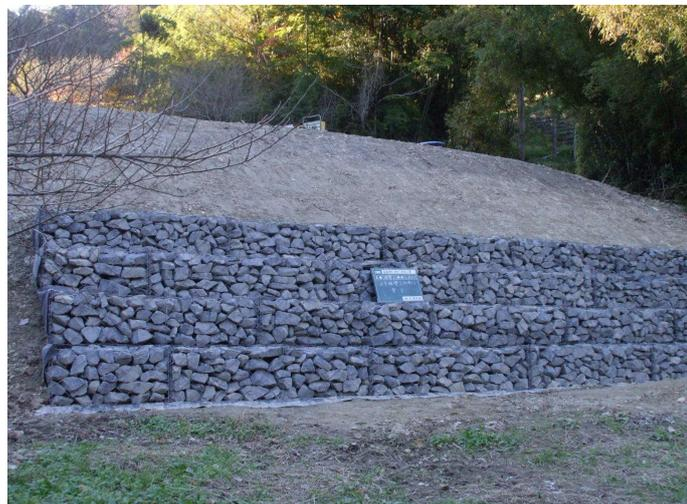
図1.9 地すべり防止工事で用いられたフトンカゴ土留工（高塚地区）
