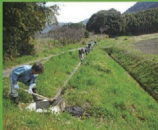
水路の泥上げ
