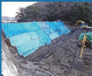
ため池の補修
