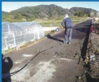
農道の整備（施工中）
