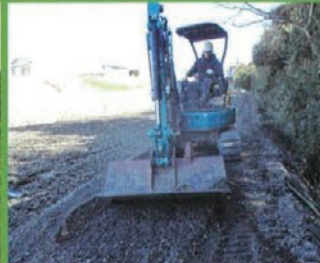
農道の維持補修
