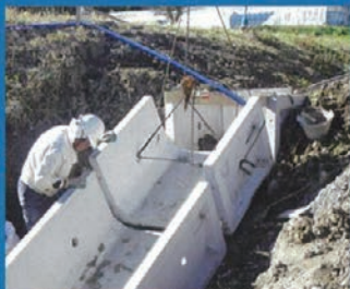
排水路の整備
