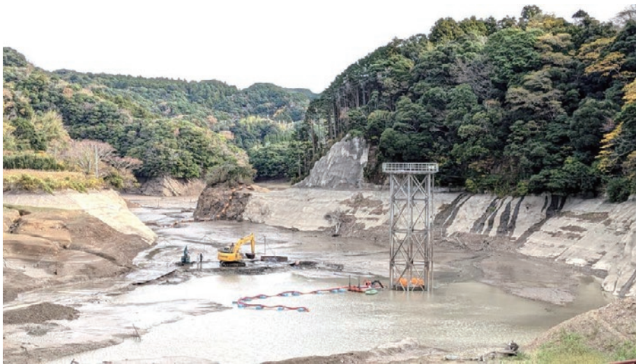
安房中央ダム取水塔底部補修工事 県営かんがい排水事業
