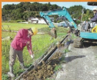
破損施設の補修
