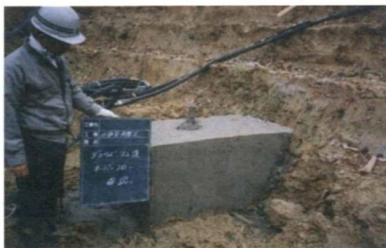
モルタルグラウトオーバーフロー確認（上流側）
