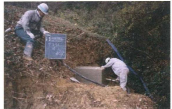
モルタルグラウト注入（下流側）
