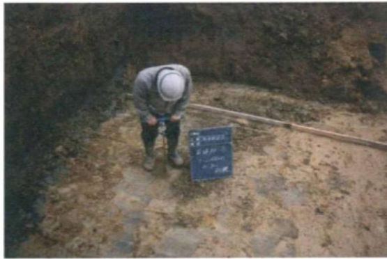
基礎地盤支持力確認
